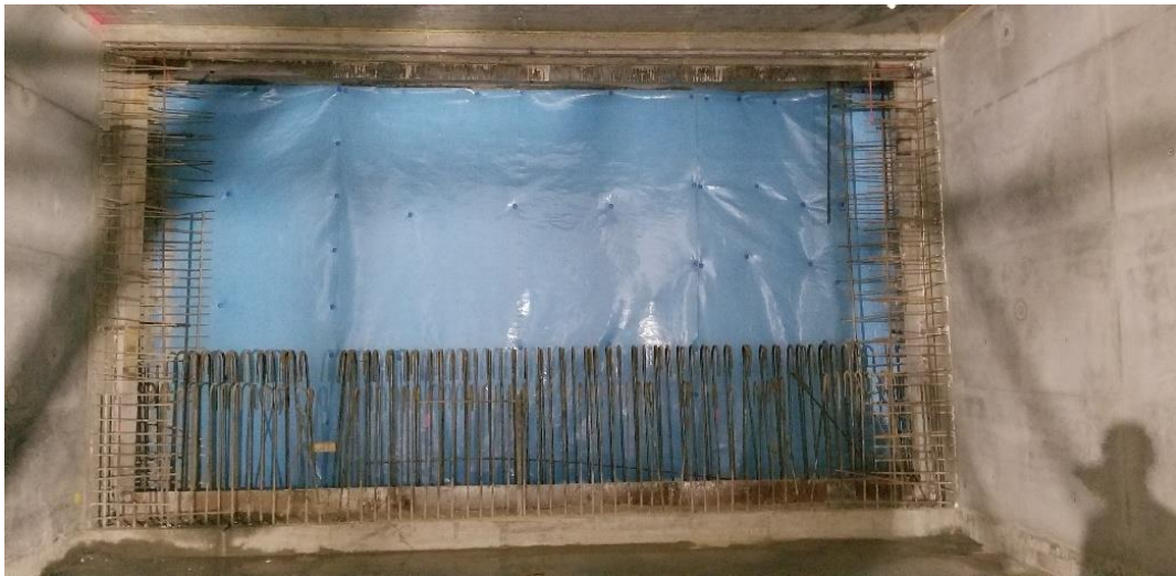
Abbildung 2.5.7: Bereitgestellte Öffnung im Notausstieg Quellenstraße zur Realisierung der Prototypenwand
