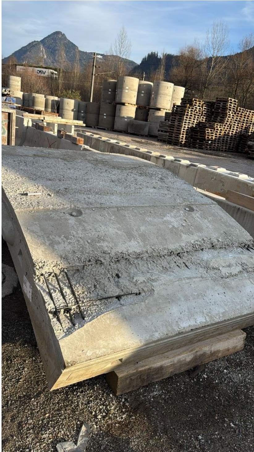
Abbildung 2.5.6: Erste Charge mit geringerem Wassergehalt, gehinderte Betonverteilung in der Schalung.
