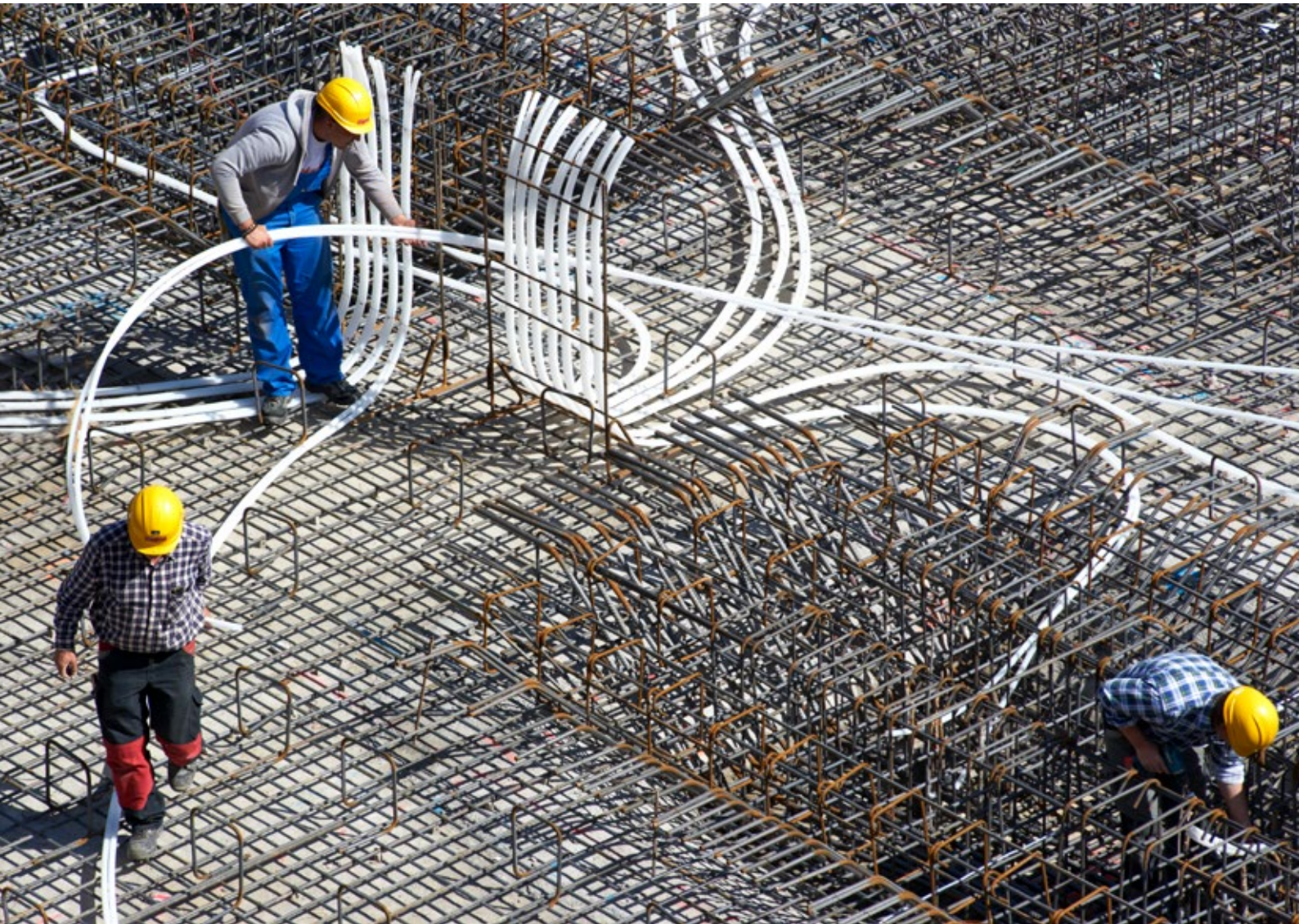
Verlegung der Verrohrung auf der Baustelle Haupt- bahnhof Wien
