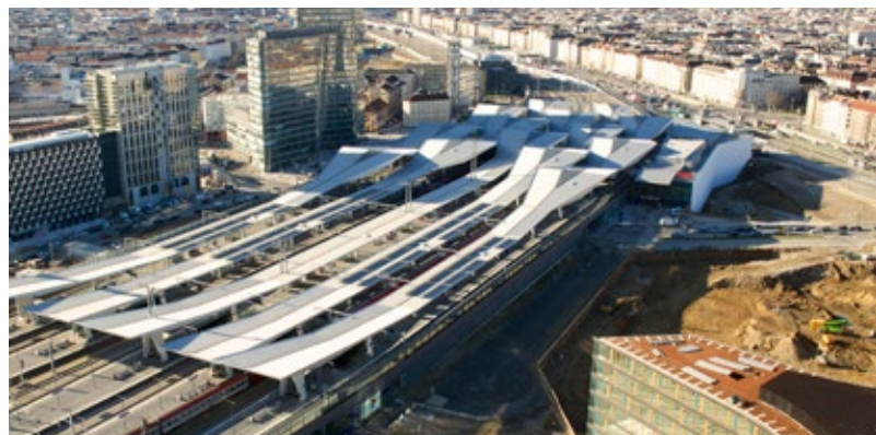
Die kooperative Projektabwicklung trug auch einen Teil dazu bei, dass die engen Zeitvorgaben bei der Errichtung des Hauptbahnhofs Wien eingehalten werden konnten.
