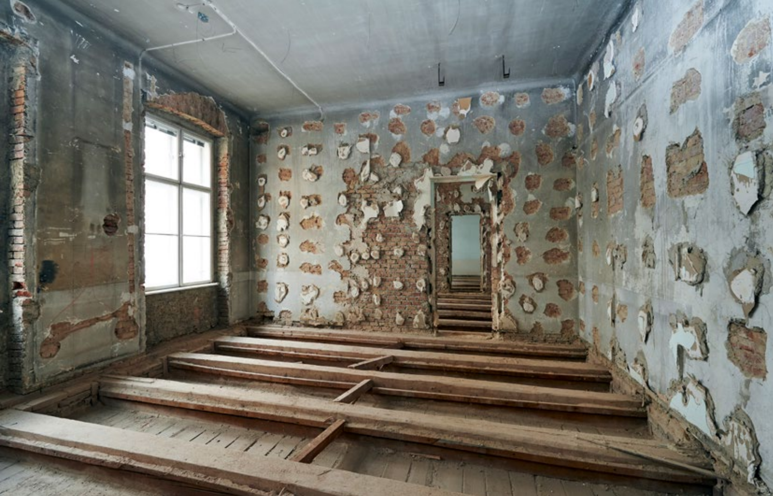
Freigelegte Tramdecke, vorbereitet zur Verstärkung, in der GESIBA-Zentrale
