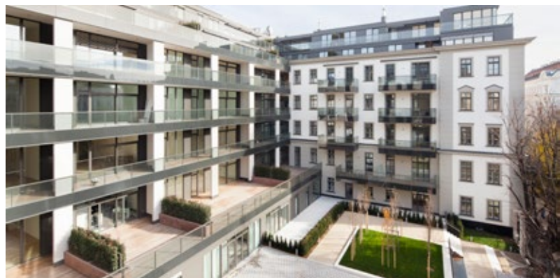
Im Rahmen des KOOP-Siegerprojekts „Das Hamerling“ entstanden aus dem ehemaligen Bundesamt für Eich- und Vermessungswesen eine Wohnanlage mit luxuriösen Apartments und eine Seniorenresidenz.
