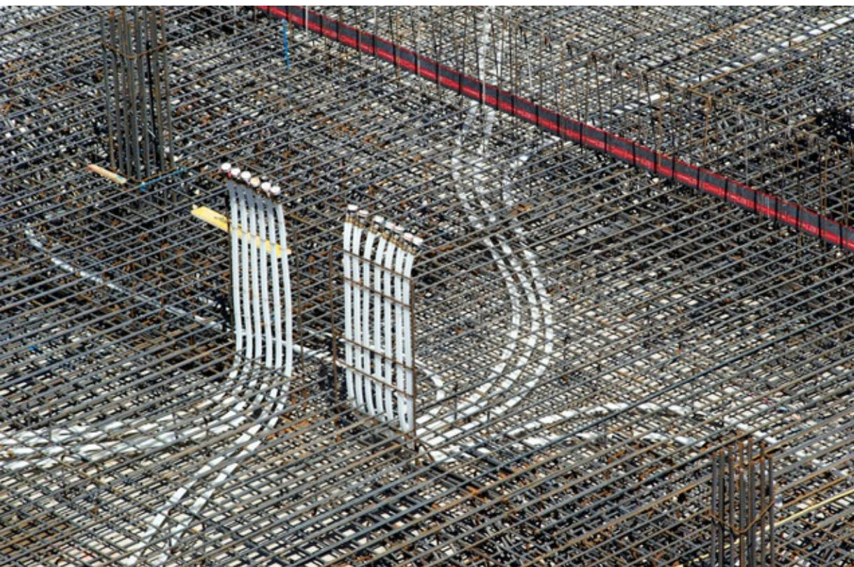
Verlegung der Verrohrung auf der Baustelle Haupt- bahnhof Wien
