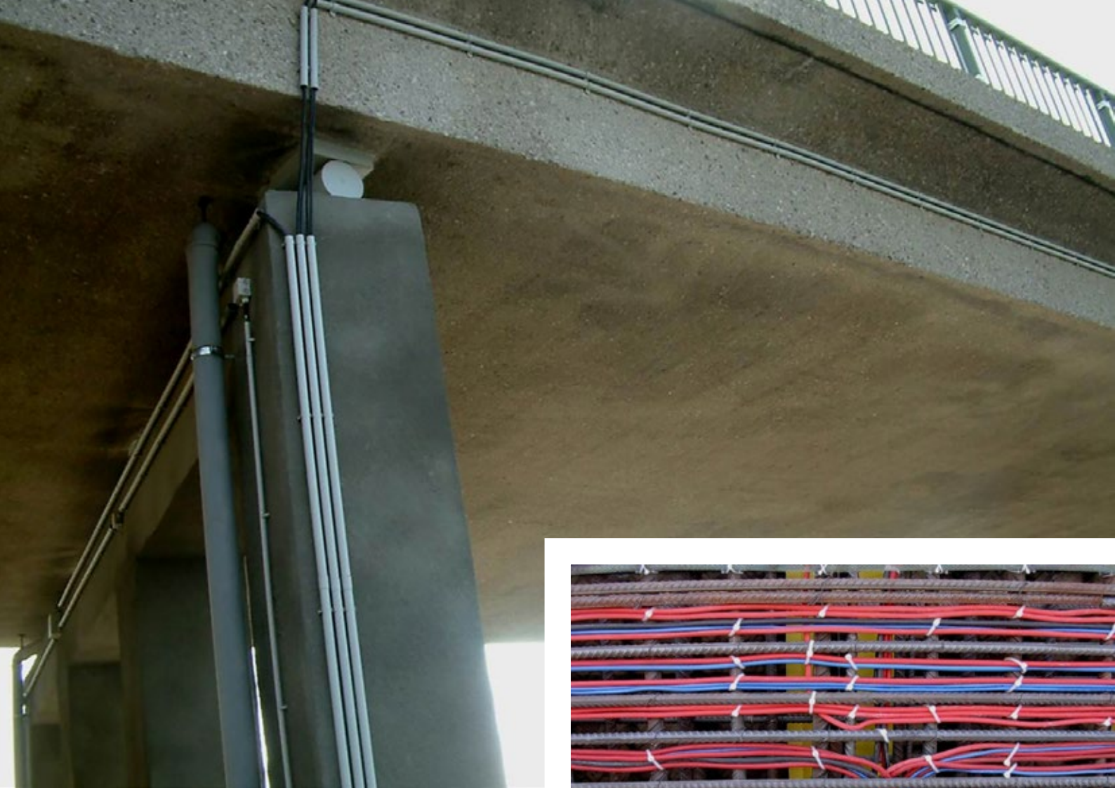
KKS für 21 bestehende Brückenbauwerke Niederösterreichs auf der A2
