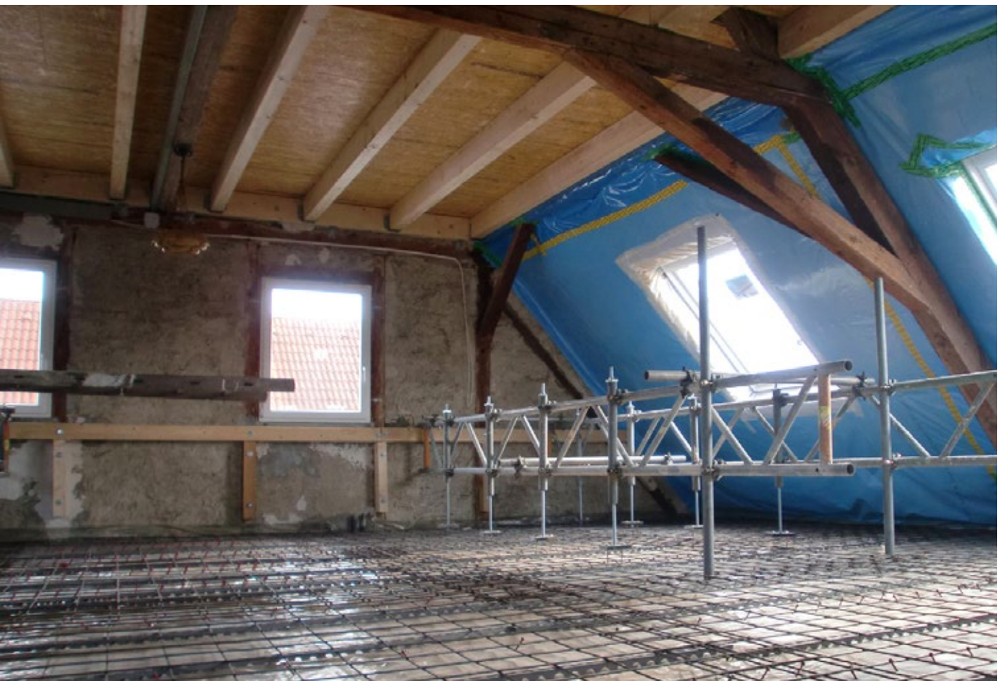
Sicherheitsniveau erhöht durch Verstärken der Tramdecke mit Stahlfaserbeton
