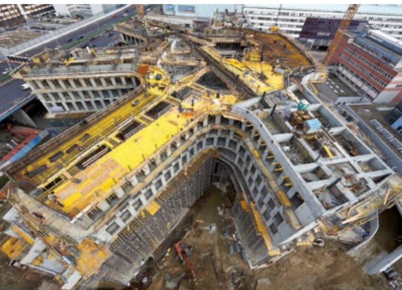
Provisorische Unterstellung des Trägerrosts Bürofinger
