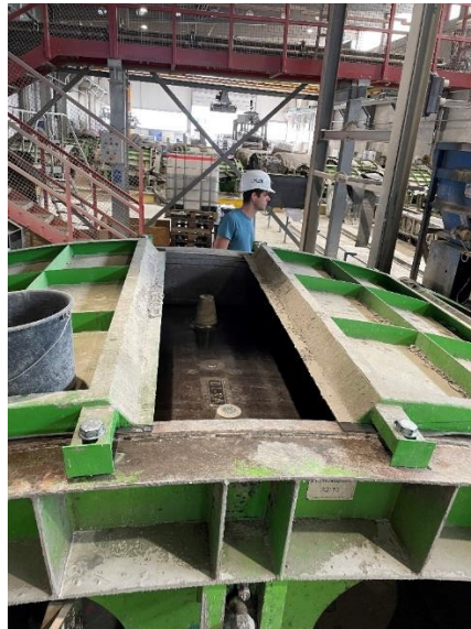
Abbildung 2: Schalung für die Herstellung der Versuchstübbinge
