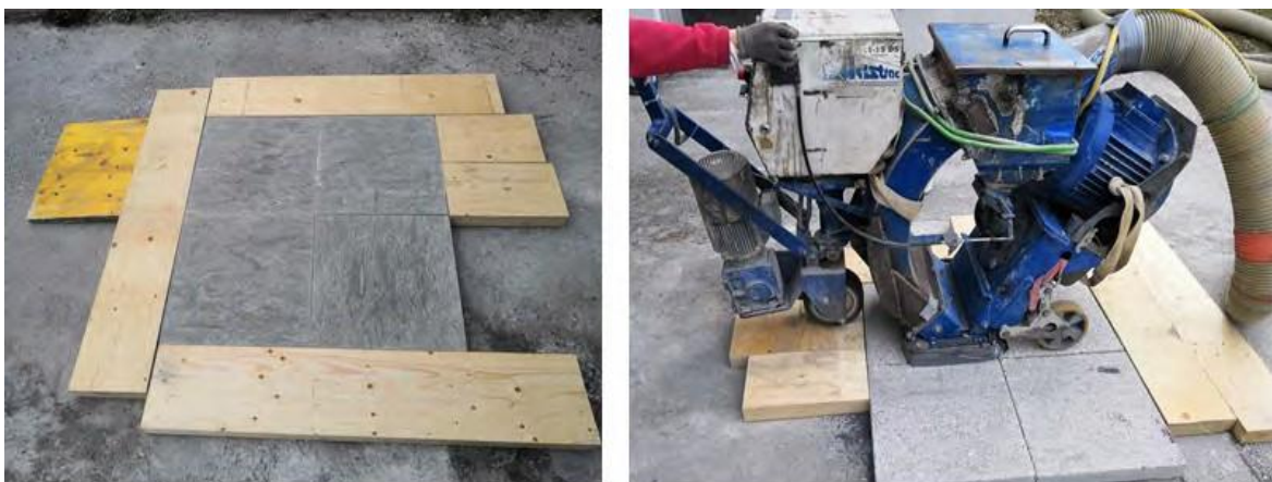
Abb. 1: Vorbereitung für Kugelstrahlen (links), Kugelstrahlen (rechts)
