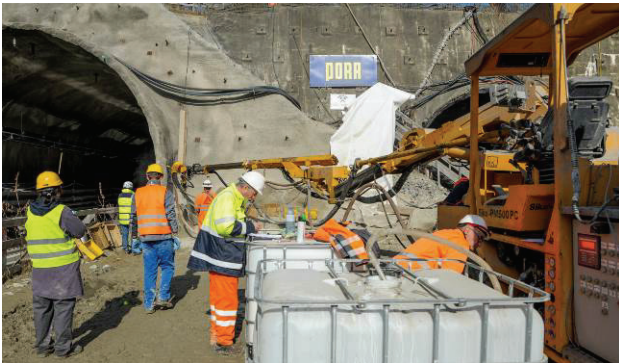
Abbildung 10: Datenermittlung und Probespritzen am Portal des Zwischenangriffes Mitterpichling
