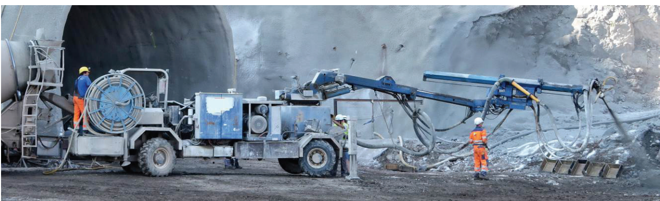
Abbildung 4: Spritzen von Probekörpern im Portalbereich
