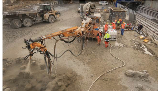
Abbildung 10: Datenermittlung und Probespritzen am Portal des Zwischenangriffes Mitterpichling
